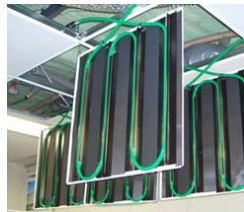
壁面・天井の輻射パネル
